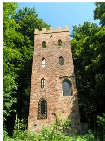
Rytířská bašta ve Wodzisławu Śl. (před rekonstrukcí)
