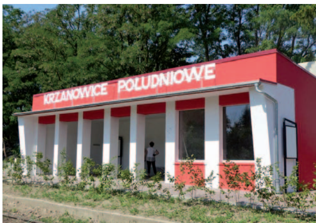
Rekonstrukcí chátrající, nevyužívané nádražní budovy v Krzanowicích bylo vytvořeno jedno z odpočinkových míst na stezce rodu Lichnovských.
